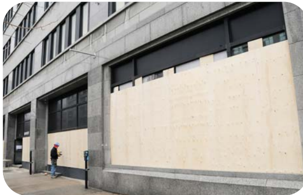
CLÔTURES ET BARRICADES SUR LE SITE OÙ LOGERA LE FUTUR CENTRE DE RECHERCHE.
